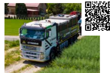
TRANSPORT I MONTAŻ ZBIORNIKA
